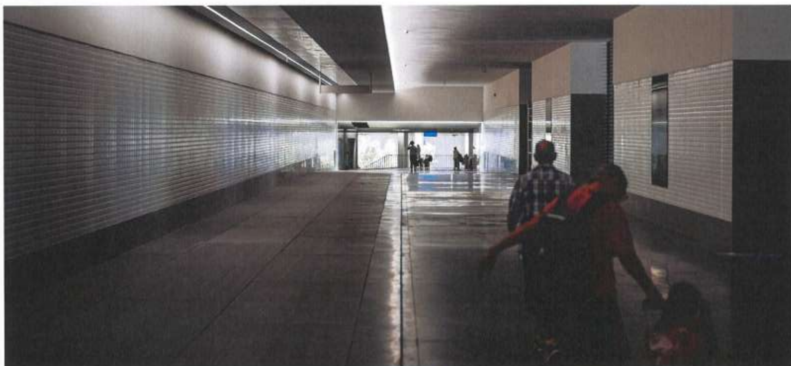
↑ Legenda Passagem Inferior Pedonal do Terminal Intermodal de Campanhã
